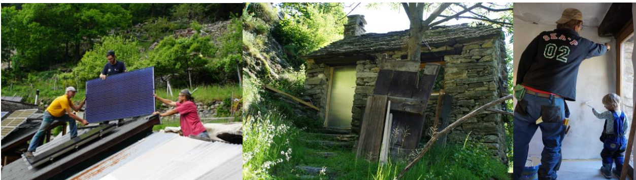
Bilder v. r. n. l.: Installation neue Photovoltaik Anlage, Türe Alpwartshaus (alte Türe wird auf neue aufgedoppelt, Streichen Cadra Küche
